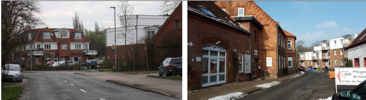
Abb. 5: links: Blick auf denkmalgeschütztes Fachwerkhaus und Wassermühle, rechts: Grundschule Barrien
