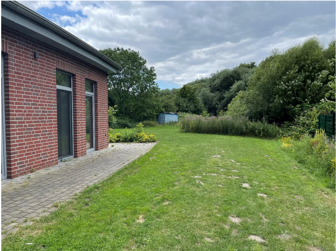
Abbildung 3-5: Blick von Osten Richtung Westen in den Garten des kirchlichen Gemeindehauses, im Hintergrund eine Ruderalflur (Foto: IDN GmbH)
