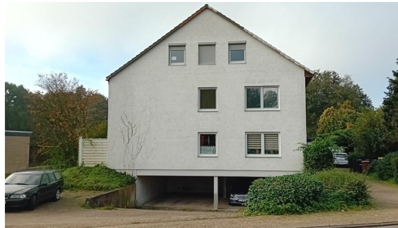
Mehrparteienhaus mit kombinierten Stellplätzen (vor und hinter dem Gebäude, offene Tiefgarage)
