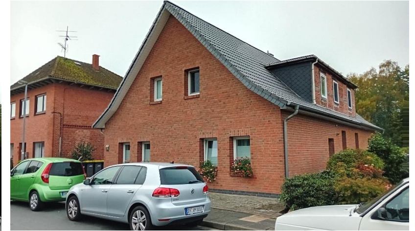
Wohngebäude mit mehreren Wohnungen ohne ausreichende Stellplätze auf dem Grundstück
