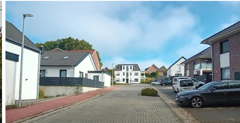
Dem Untersuchungsraum gegenüberliegendes Neubaugebiet mit mehreren MFH, Reihenhäusern usw., Steimker Str. 37-55
