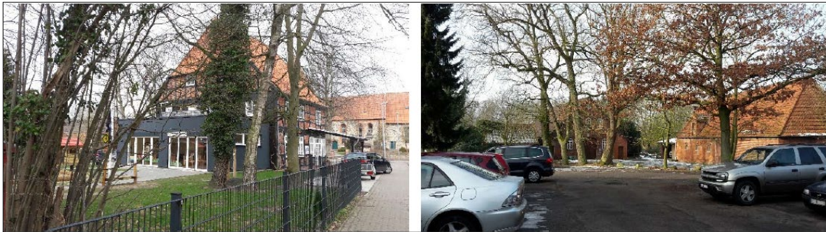
Abb. 9: links: Altes Pfarrhaus mit Anbau, rechts: ehemalige Hofstelle
