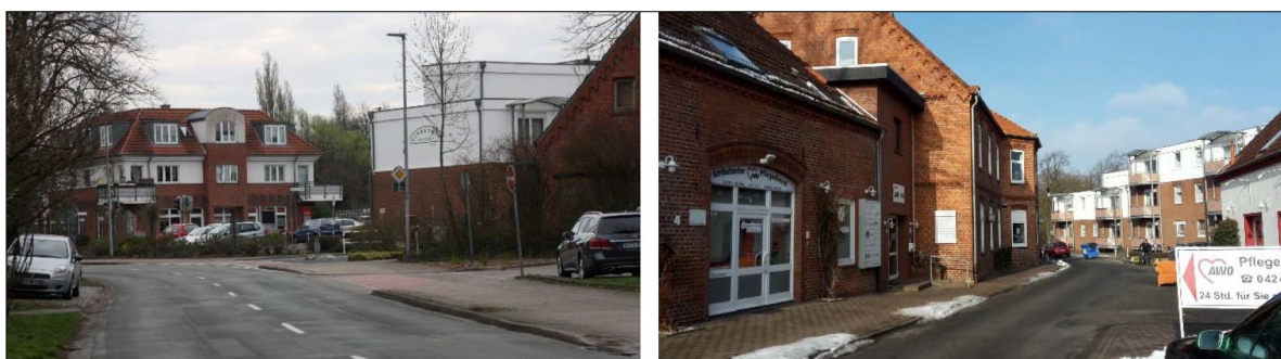
Abb. 6.: Links: Blick von „An der Wassermühle“ auf Neubauten Barrier Straße, rechts: Blick aus der Glockengießerstraße in Richtung „An der Wassermühle“/ Seniorenwohnanlage
